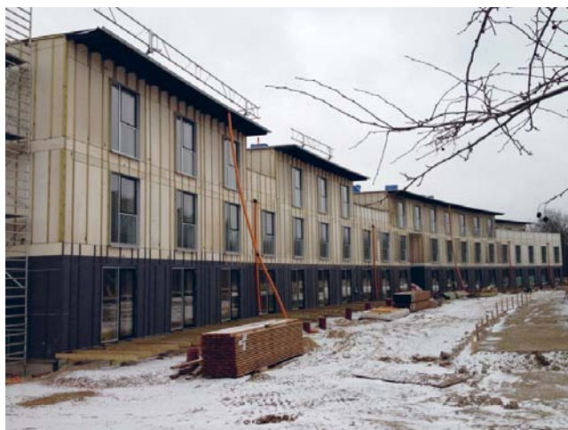
AlmenBolig+ bebyggelse under opførelse i Rødovre for Boligselskabet AKB, Rødovre.
